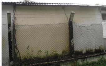
Fotografía 1 nido de termitas
