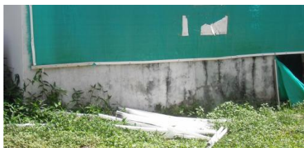
Fotografía 7 residuos peligrosos inadecuadamente dispuestos
