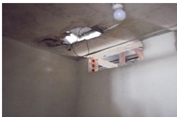
Foto 32. Techo del lugar de almacenamiento de residuos orgánicos de la cocina.
